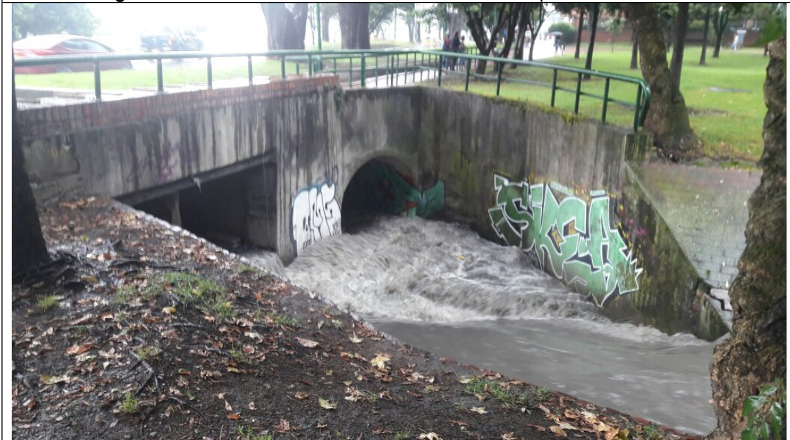
Fotografía 2. Punto de Intervención sobre estructura existente, con coordenadas Norte: 108727.941; Este: 102090.124
